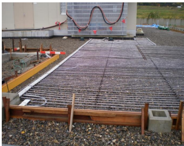
SECT式ヒーター設置状況
