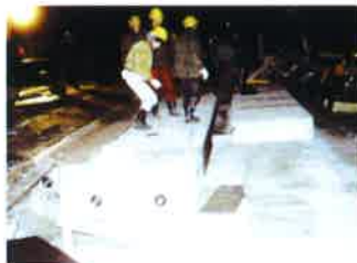
ヒーター設置
