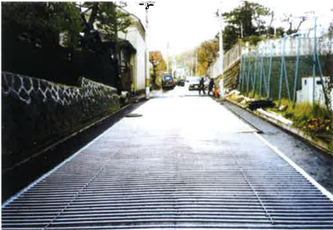
ヒーター設置
