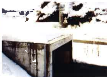
ヒーター運転状況
