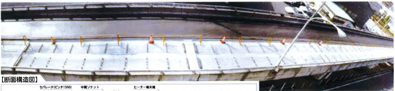
ヒーター設置
