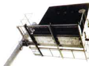
ヒーター設置
