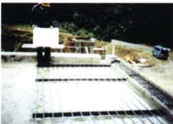
ヒーター設置
