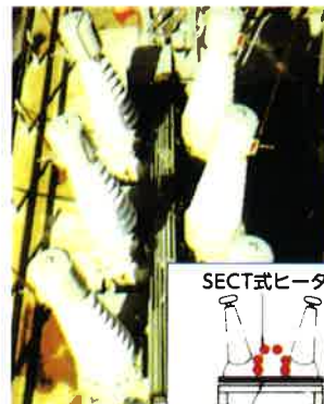
OCB(油入遮断器)融雪ヒーター
